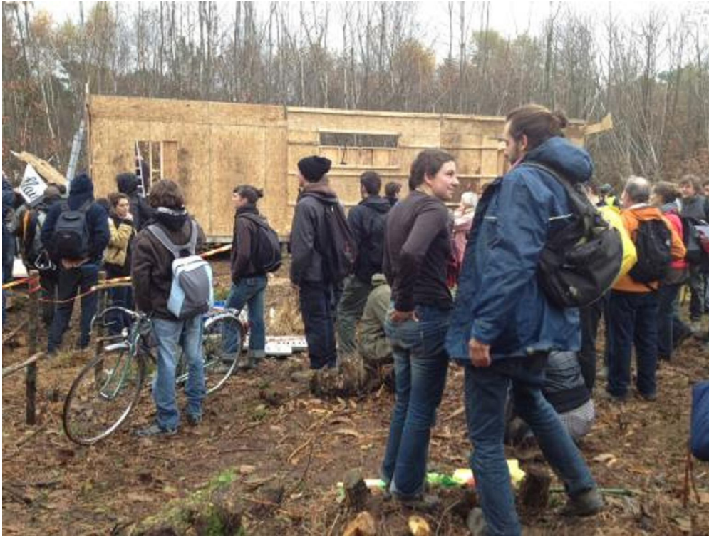
Premières heures de construction des cabanes de la Châtaigneraie (JL)
